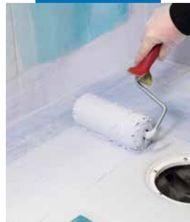
Mapegum WPS -vedeneristettä levitetään telalla
