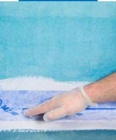
Mapei ST -vahvikenauhan asennus Mapegum WPS- vedeneristettä käyttäen, lattia/seinä -liittymässä
