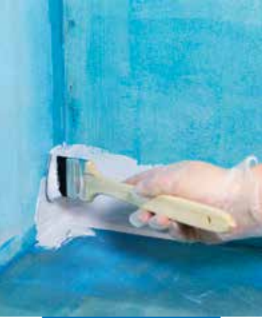
Mapei IC/EC -kulmakappaleen asennus Mapegum WPS -vedeneristettä käyttäen
