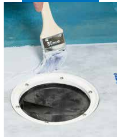
Butyylinen kaivokappale (itsekiinnittyvä) asete-taan lattiakaivon päälle (pohjustetulle alustalle). Levitä tämän jälkeen Mapegum WPS -vedeneriste kahteen kertaan
