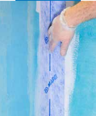
Mapei ST -vahvikenauhan asennus Mapegum WPS:ää käyttäen, seinä
