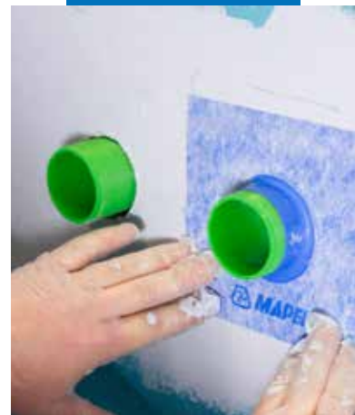
Mapeguard PC -läpivientikappale asennettuna Mapegum WPS -vedeneristeellä
