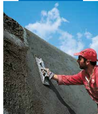
Mapegrout T40 -pinnan viimeistely
