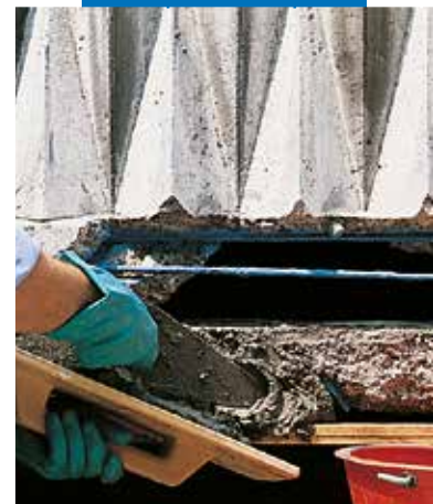
Parvekkeen korjaaminen Mapegrout T40:tä käyttäen
