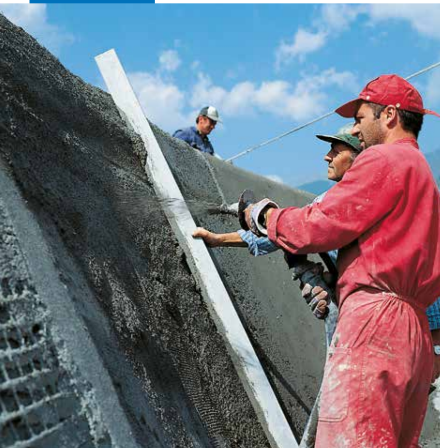
Mapegrout T40:n levittäminen ruiskulla
