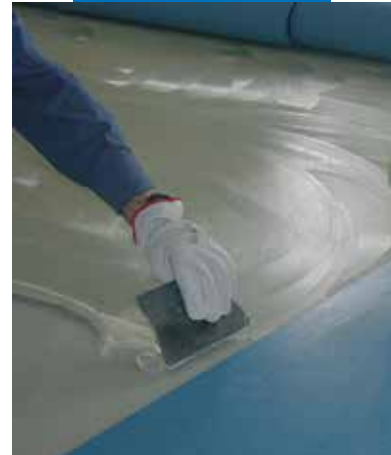
Ultrabond Eco V4 SP -liimaa levitetään - San Martinon lepokoti - Italia
