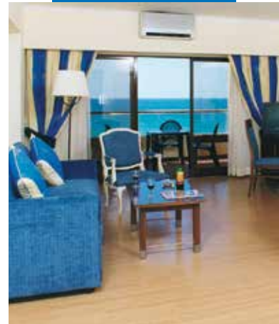
PVC-lattianpäällystettyä asennetaan hotellihuoneeseen - Iber Hotel - Portugali
