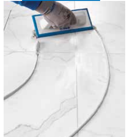
Ultracolor Plus-levitys kumilastalla marmorikuvioiselle porcellanato-lattialaattalle
