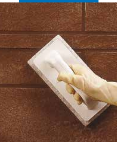
Jo osittain kovettuneen saumauksen puhdistus Scotch-Brite®-hankauslevyllä
