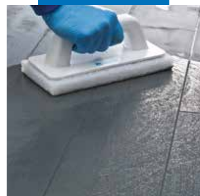
Puoliksi kovettuneen saumauksen puhdistus Scotch-Brite®-hankauslevyllä
