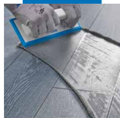
Ultracolor Plus-levitys puukuvioiselle porcellanato-lattialaatoille
