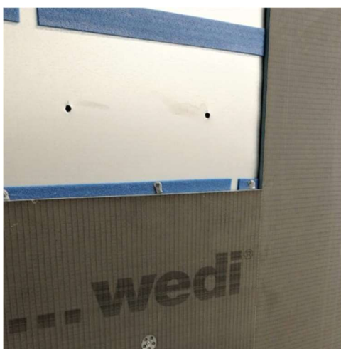
Kuva 1. Tarrakiinnitteinen irrotuskaista
