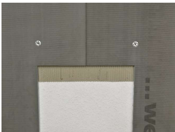
Kuva 1. Laastipeittokiinnitys + kiinnikkeet
