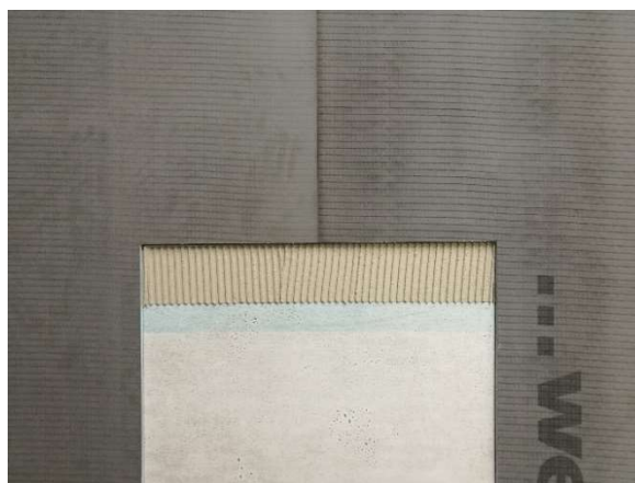
Kuva 2. Laastipeittokiinnitys + pohjustettu alusta
