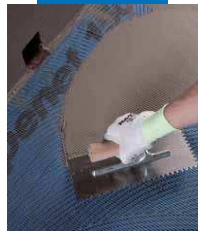
Mapelastic-vedeneristeen levitys Mapenet 150-lasikuituverkon päälle
