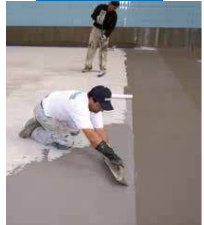
Mapelastic-vedeneristeen asennus uima-altaaseen
