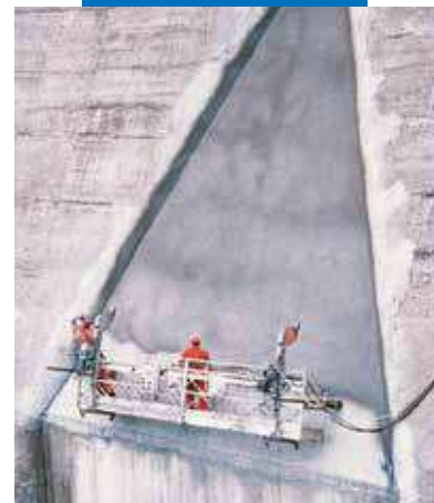
Patorakenteen Mapelastic -suojaus ruiskuttamalla
