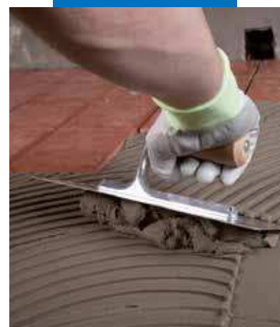
Granirapid-laatoitus Mapelastic-vedeneristeen päälle
