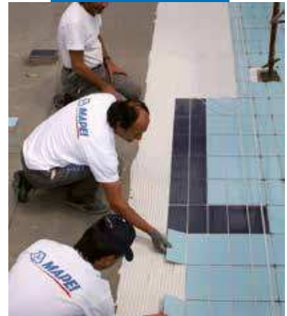
Laatoitus Mapelastic-vedeneristeen päälle uima-altaassa
