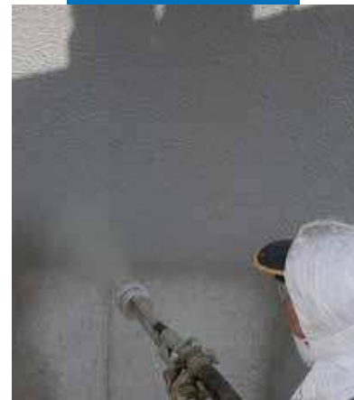
Viaduktin Mapelastic -suojaus ruiskuttamalla
