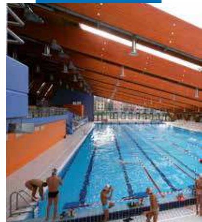
Mapelastic-vedeneristetty uima-allas, Scarioni Leisure Center, Milano - Italia
