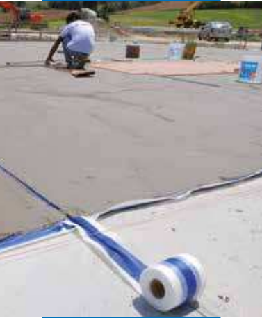
Betonialustan vedeneristäminen Mapelastic- ja Mapeband-tuotteilla
