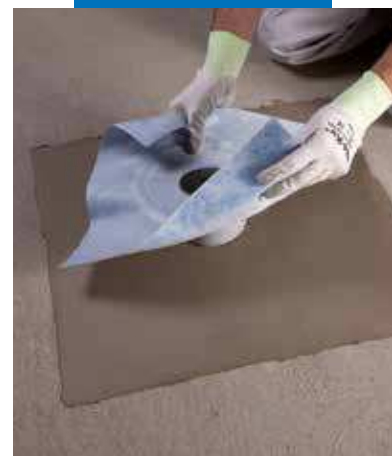
Lattiakaivokappaleen asennus Mapelastic-vedeneristeeseen
