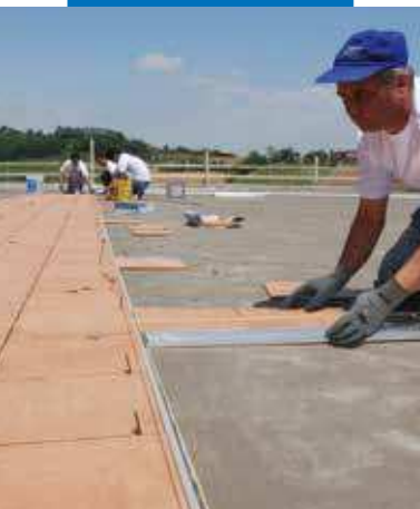
Laattojen asennus Kerabond + Isolastic-tuoteyhdistelmällä
