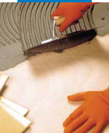
Elastorapid-laatoitus vedenkestävästi liimatulle vanerille
