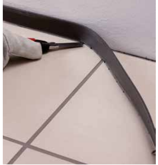
Saumauksen valmistuttua leikkaa pois ylimääräinen Mapesonic Strip -irrotuskaista.
