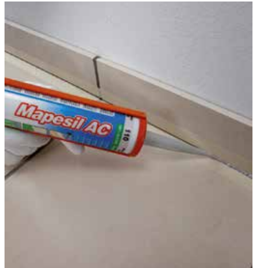
Täytä jalkalistan ja lattian välinen rako soveltuvalla Mapei-tiivistysmassalla.
