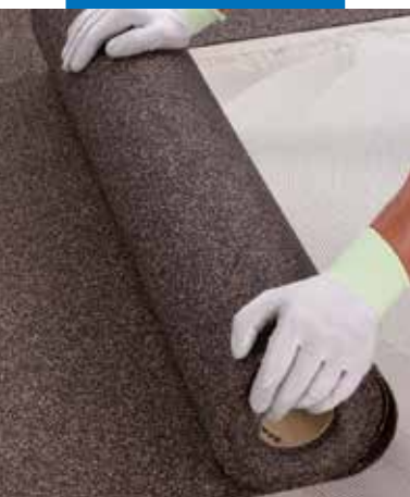
Asenna Mapesonic CR -vuodat
