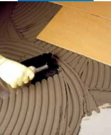
Elastorapid lattialaatoituksessa
