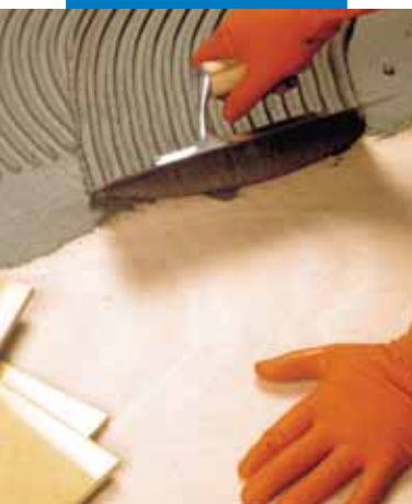
Elastorapid-laatoitus vedenkestävästi liimatulle vanerille
