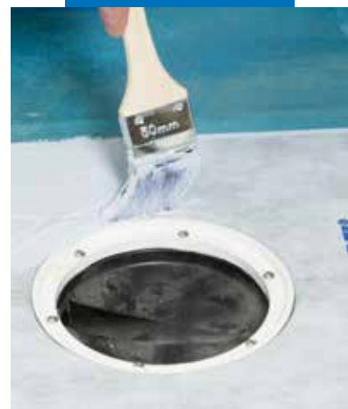
Butyylinen kaivokappale (itsekiinnittyvä) asetaan lattiakaivon päälle (pohjustetulle alustalle). Levitä tämän jälkeen Mapegum WPS -vedeneriste kahteen kertaan
