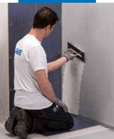
Kiinnityslaastin levittäminen
