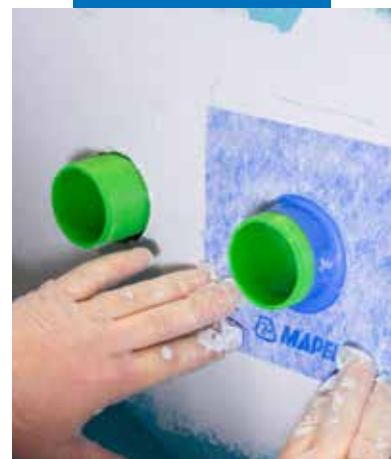
Mapeguard PC -läpivientikappale asennettuna Mapegum WPS -vedeneristeellä
