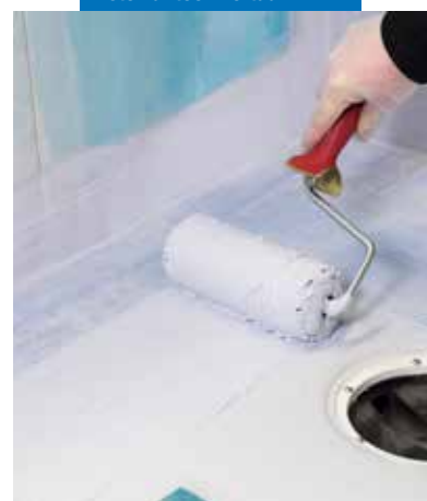
Mapegum WPS -vedeneristettä levitetään telalla
