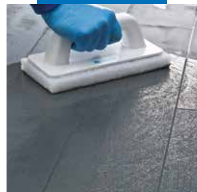
Puoliksi kovettuneen saumauksen puhdistus Scotch-Brite®-hankauslevyllä
