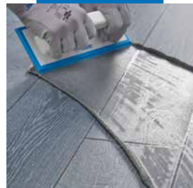
Ultracolor Plus-levitys puukuvioiselle porcellanato-lattialaattalle
