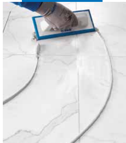
Ultracolor Plus-levitys kumilastalla marmorikuvioiselle porcellanato-lattialaatalle
