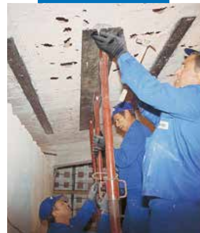
Teräsvahvikkeen asennus rakenteellisessa korjauksessa
