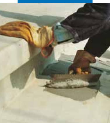
Adesilex PG1:n levitystä hammaslastalla portalla
