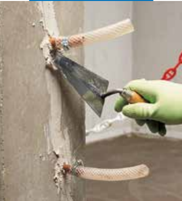
Halkeamien täyttämistä ennen injektointia
