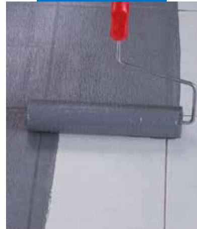
Eco Prim Grip -pohjusteen levitys telalla vanhalle porcellana- tolaattalattialle
