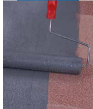
Eco Prim Grip -pohjusteen levitys telalla vanhalle terrazzolattialle
