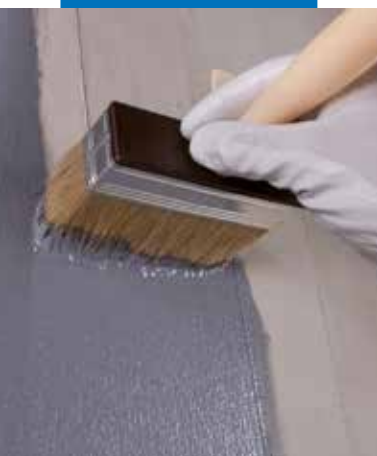
Eco Prim Grip -pohjusteen levitys siveltimellä betonialustalle
