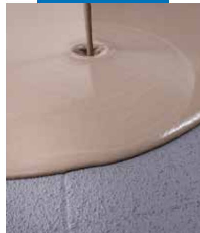
Itsesiliävän Ultraplan- tasoitteen levitys Eco Prim Grip -pohjustetulle vanhalle lattialle
