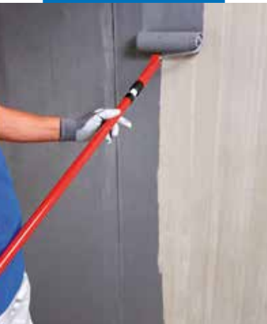
Eco Prim Grip -pohjusteen levitys telalla betonialustalle
