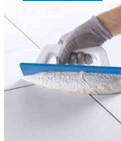
Levitä Kerapoxy Easy Design Mapei-lastalla
